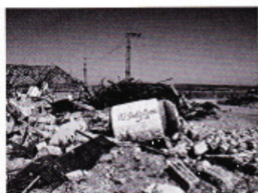
N3003-100 Quartier: Jabalya Nord; voisinage: Al-Moqadima; date de destruction: 8 janvier 2009; méthode de destruction: bulldozer; date d'inspection: 29 avril 2009; état du bâtiment: ruines.
