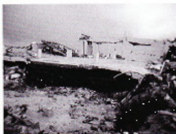
N3003-106 Quartier: Jabalya Nord; voisinage: As-Salam; date de destruction: 9 janvier 2009; méthode de destruction: bombardement aérien; date d'inspection: 3 mai 2009; état du bâtiment: ruines.
