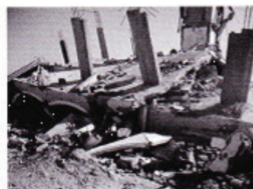
N3003-121 Quartier: Jabalya Nord; voisinage: As-Salam; date de destruction: 9 janvier 2009; méthode de destruction: bulldozer; date d'inspection: 6 mai 2009; état du bâtiment: ruines.
