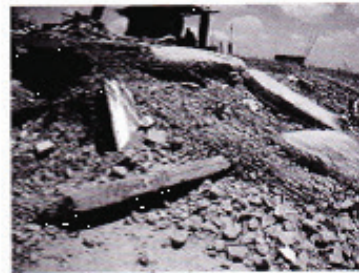
N3003-118 Quartier: Jabalya Nord; voisinage: As-Salam; date de destruction: 9 janvier 2009; méthode de destruction: bulldozer; date d'inspection: 5 mai 2009; état du bâtiment: ruines.
