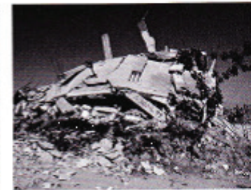
N3004-99 Quartier: Jabalya Nord; voisinage: /; date de destruction: 8 janvier 2009; méthode de destruction: bombardement; date d'inspection: 29 avril 2009; état du bâtiment: ruines.
